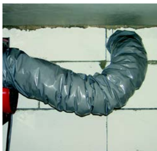
Korrekte Montage, großer Biegeradius.
