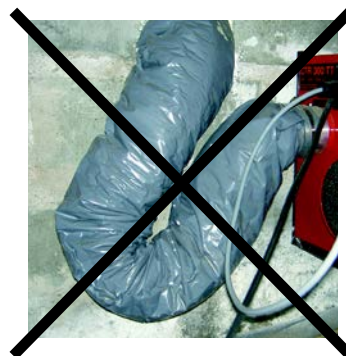
Falsche Montage, zu kleiner Biegeradius
