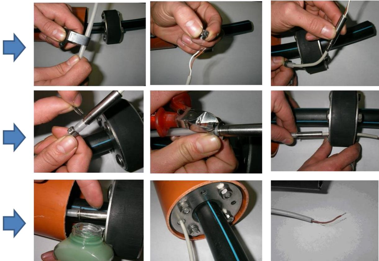
**Abbildung 50: Installation des Anschlusskabels mit Schutzschlauch in Dichtungssatz der Hauseinführung**
