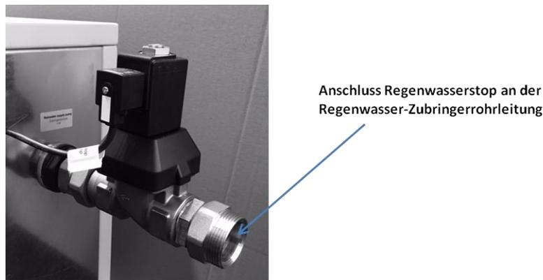
Abbildung 46: hydraulischer Anschluss des Regenwasserstops
