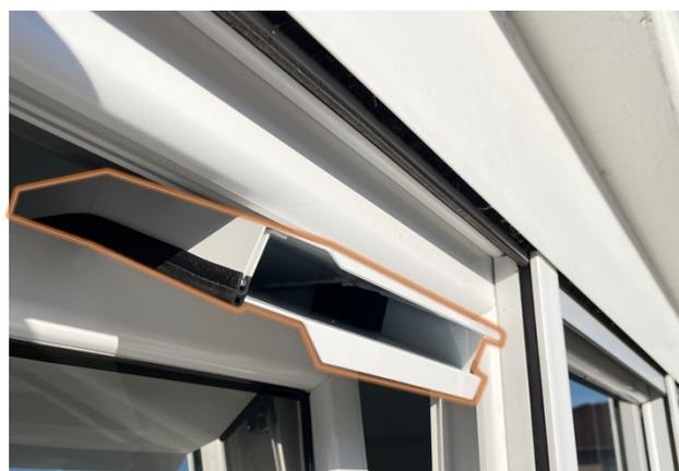
Abbildungen zeigen die eingesetzte Fensterabluftdüse TA 160 + Adapter im gekippten Fenster (Innen- und Außenansicht).
